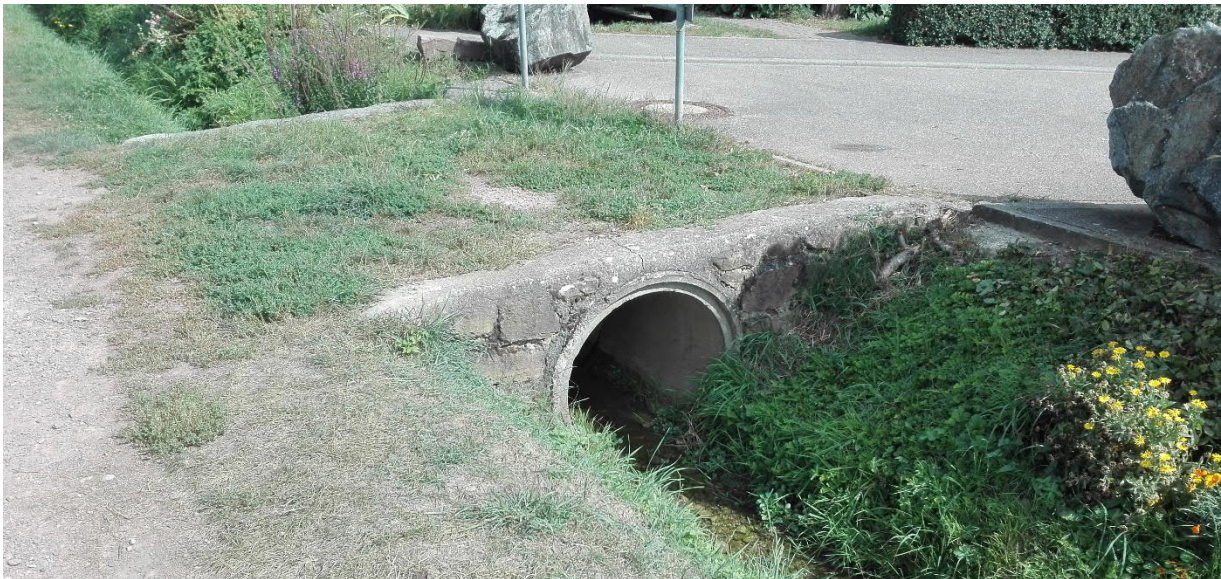
Abbildung 1: Durchlass DN 800 bei Querprofil 0+504,58 (Blick in Fließrichtung, Zustand vor Wegerhöhung)
